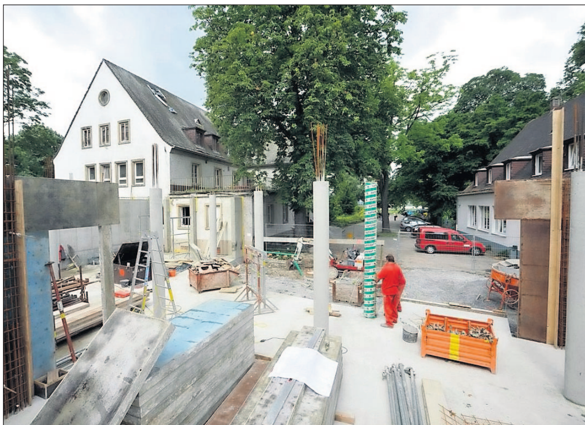
Die Jugendherberge breitet sich am Rhein aus: Sie erhält derzeit ein komplett neues Gebäude und nutzt künftig auch das gegenüberliegende Friedrich-Ebert-Wohnheim (links im Bild). FOTO: KUNZ
